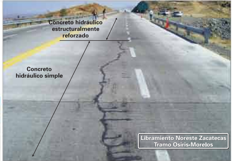
El agrietamiento longitudinal se interrumpe al llegar al concreto estructuralmente reforzado.
