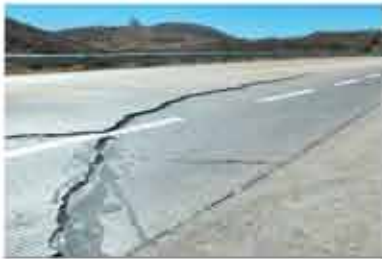
El agrietamiento longitudinal se interrumpe al llegar al concreto estructuralmente reforzado.
